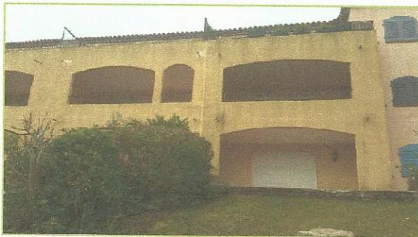
*Développement micro organismes salissures par écoulement*
