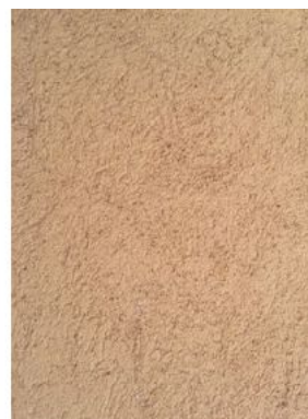
Support existant : enduit hydraulique monocouche frottassé
