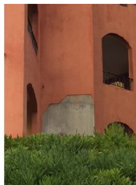
Décollement de l'enduit, sur le béton, par plaques.
