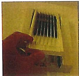
La grille se démonte en tirant légèrement sur la partie basse et en basculant
