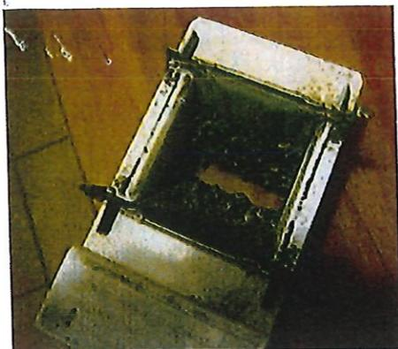
Avec le temps le passage d'air et les volets mobiles s'encrassent ; réduisant le passage ou bloquant les volets.
