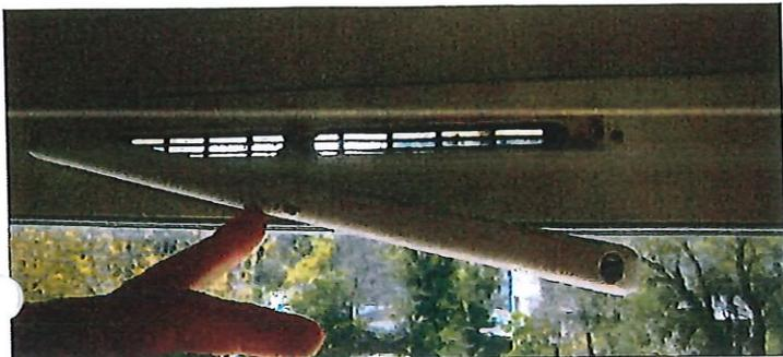
Entrée d'air haute en cours de démontage pour nettoyage
